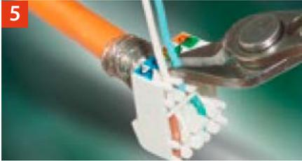
Die überstehenden Aderenden so dicht wie möglich am Aufteiler abschneiden.
