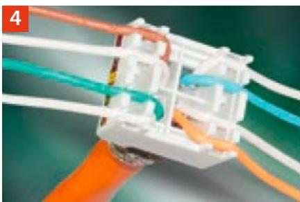
Kabeladern entsprechend dem aufgedruckten Farbcode (T 568A oder T568B) einlegen und fixieren.
